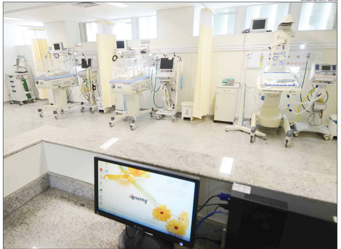
O centro de tratamento neonatal e pediátrico recebeu instalações modernas
