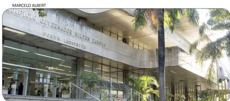
O Fórum Lafayette fica na avenida Augusto de Lima, 1549
