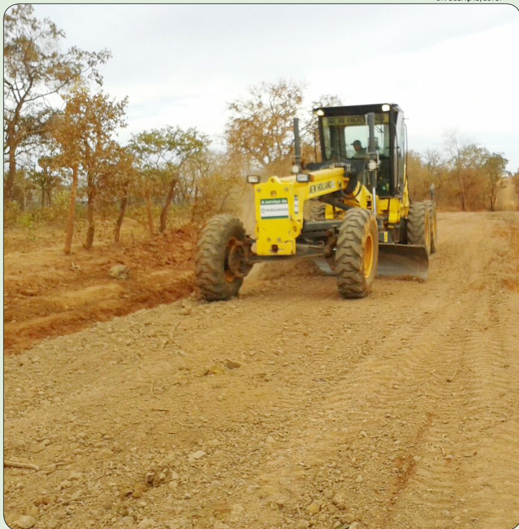
Aquisição de máquinas foi uma das linhas de crédito solicitadas
